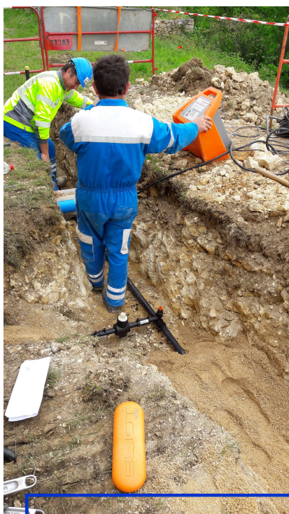
Entreprise ERCTP avec l'appa- reil de soudure à petit bout. Sur le bas de la photo le bloc ELIOT (orange) qui renfermera la puce d'identification de la canalisation.
