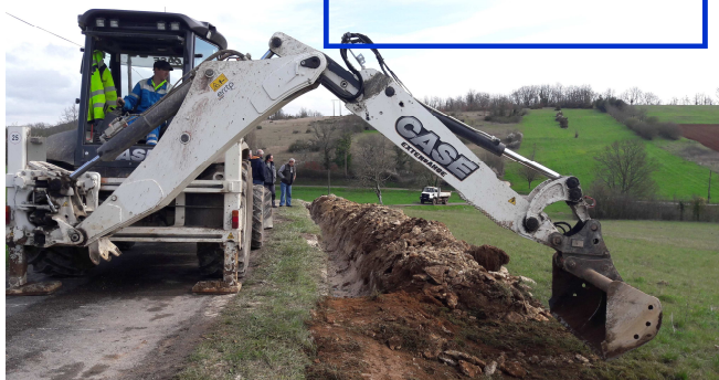
Entreprise ERCTP aux gipoux - fermeture d'une tranchée
