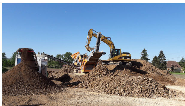
Chargement du malaxeur— la ma- laxeuse traite les déchets qui sont chaulés pour remplacer le calcaire de carrière. A ce jour 900 tonnes ont été re- traitées et d'ici la fin des travaux on de- vrait en compter le double.
